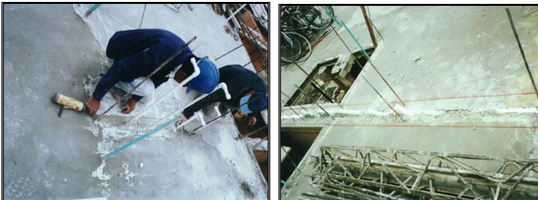
Fotos 203-204. Localización de muros en placas
