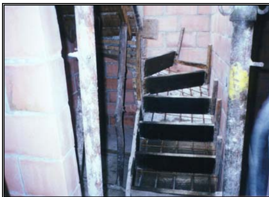
Fotos 262-263-264 Testeros transversales y longitudinales- Vista de refuerzo escalera
