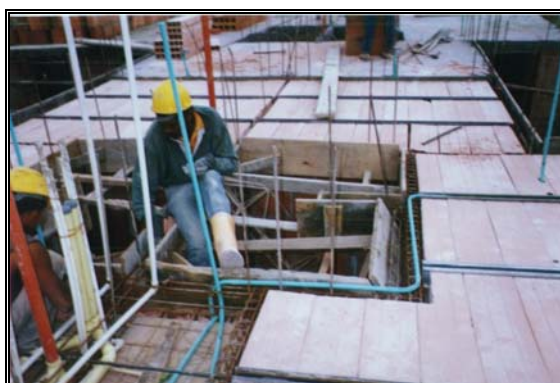
Fotos 253-254. Placa en perfiles de acero y aligeramiento en bloques de arcilla
