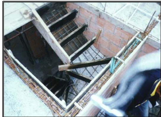
Fotos 262-263-264 Testeros transversales y longitudinales- Vista de refuerzo escalera
