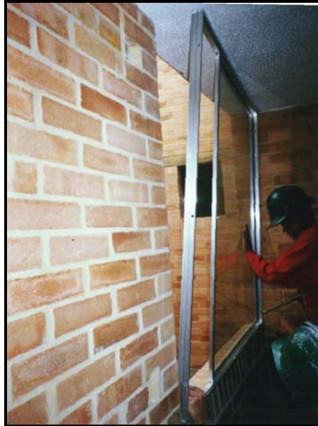
Foto 365 Ajuste preciso de ventana en aluminio
