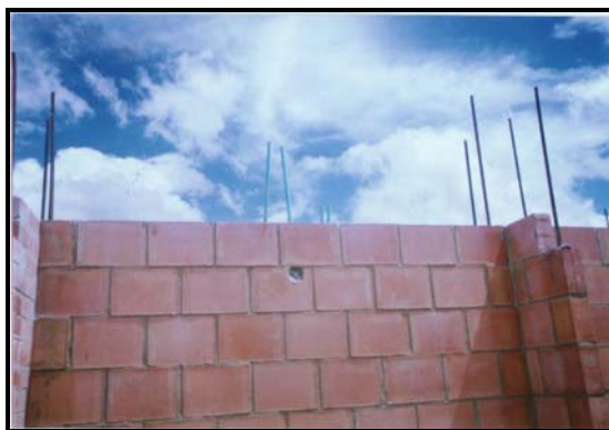
Foto 201. Prolongación de refuerzos para muros en niveles superiores
