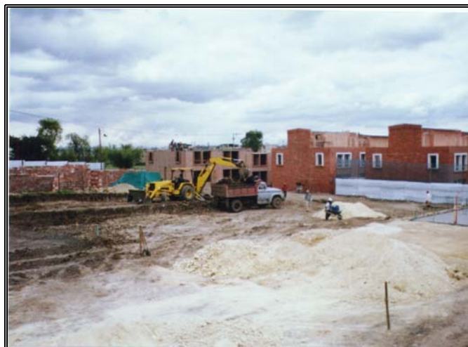
Foto 163 Excavación hasta suelo de fundación
