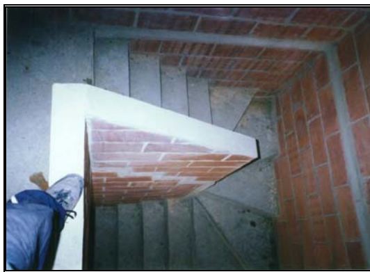
Foto 255 Espacio típico para caja de escalera en VIS
