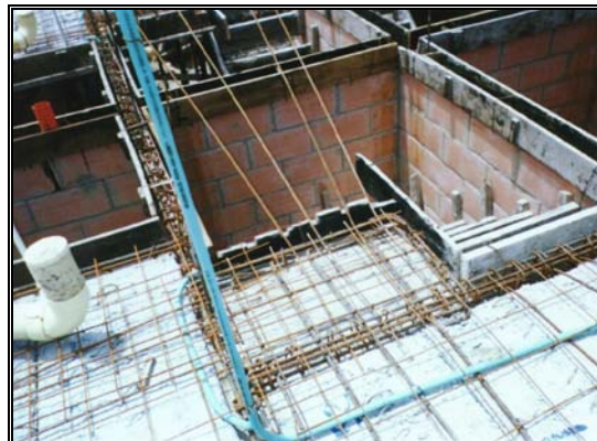
Foto 256. Refuerzos de escalera amarrados a refuerzo de placa
