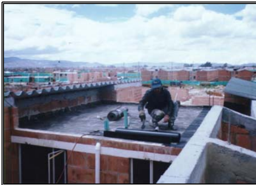
Fotos 303-304-305-306 Impermeabilización de cubiertas
