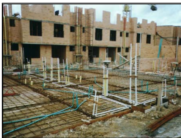
Foto 184 Tendido de instalaciones
