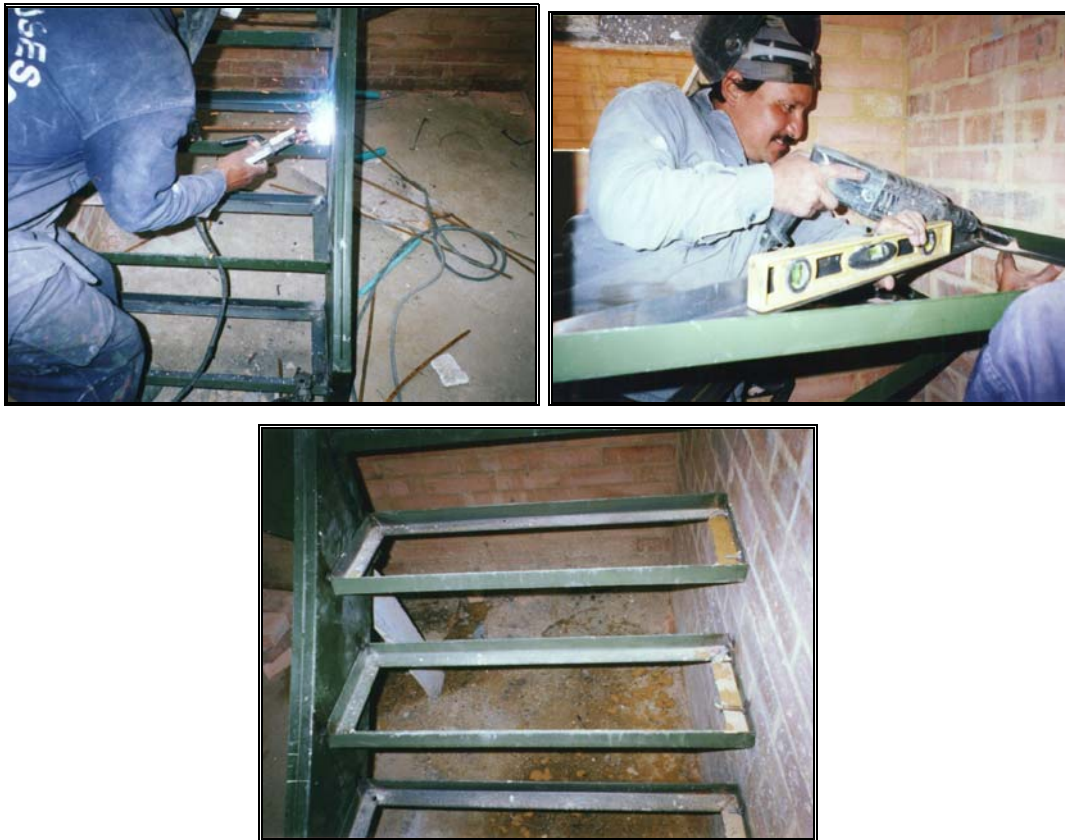
Fotos 285-286-287 Nivelación, soldadura y vista de apoyos para escalones
