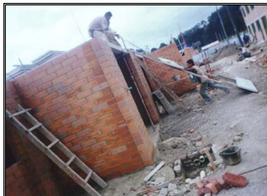
Foto 245-246 Transporte y Ascenso de prelosas
