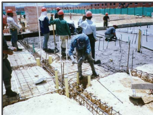
Foto 180 Hilos guía para control de nivel
