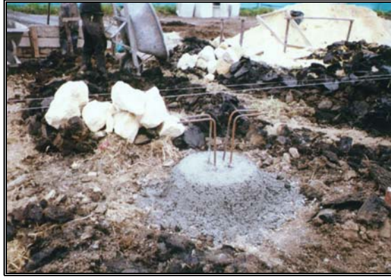
Foto 195 Cabeza y pelos de micropilotes
