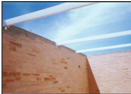
Fotos 309-310-311 Correas en lámina y elementos de fijación
