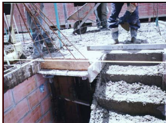
Foto 240 Hilos guía para control de nivel de placa
