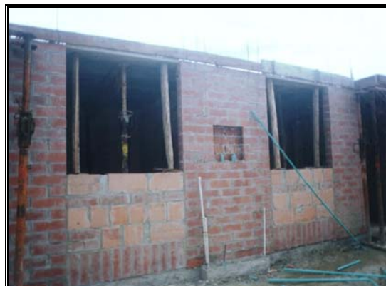
Foto 237-238. Testeros internos (alrededor de escalera) y externos
