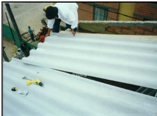
Foto 315 Colocación de tejas. Vista externa
