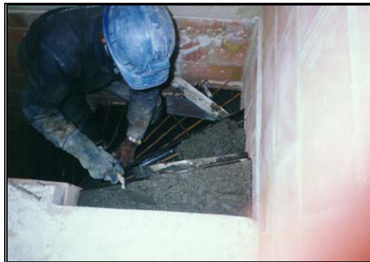
Foto 272 Vaciado de concreto para cada peldaño
