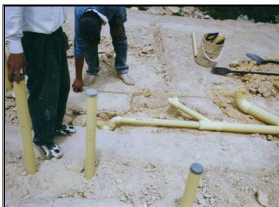
Foto 340 Comprobación de medidas para la red sanitaria
