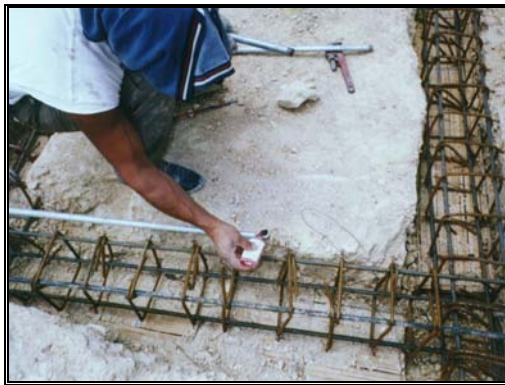
Fotos 328-329-330 Instalación típica tubería para gas. A.Galvanizado
