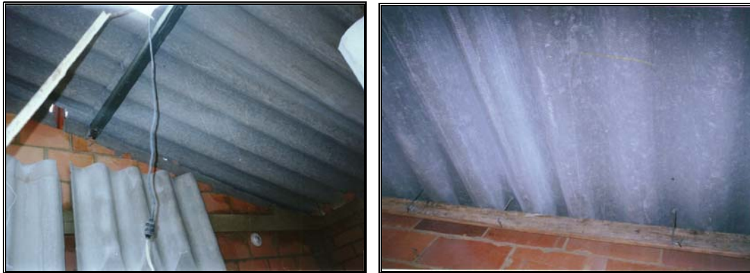
Fotos 320-321 Vista interior de fijación de correas mediante ganchos
