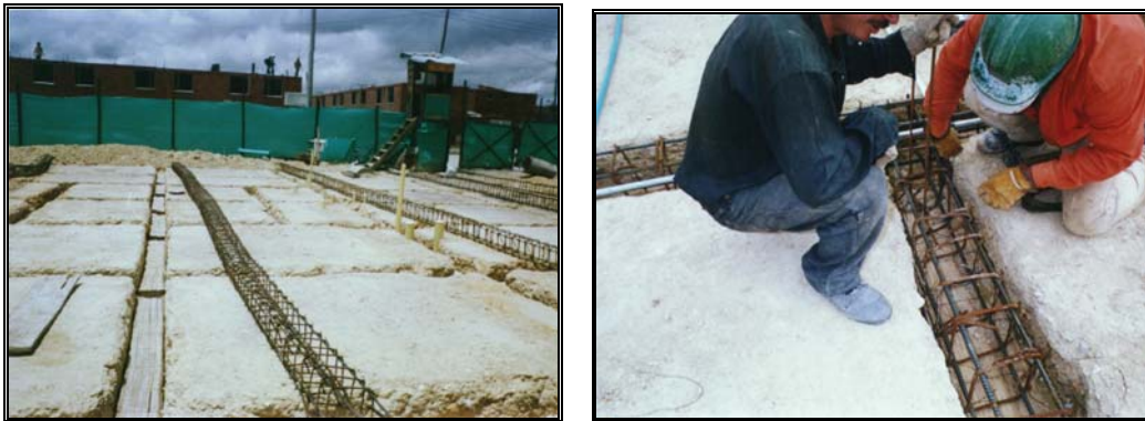
Fotos 175-176 Configuración refuerzo de vigas de cimentación y amarre de arranque de refuerzo vertical para mampostería
