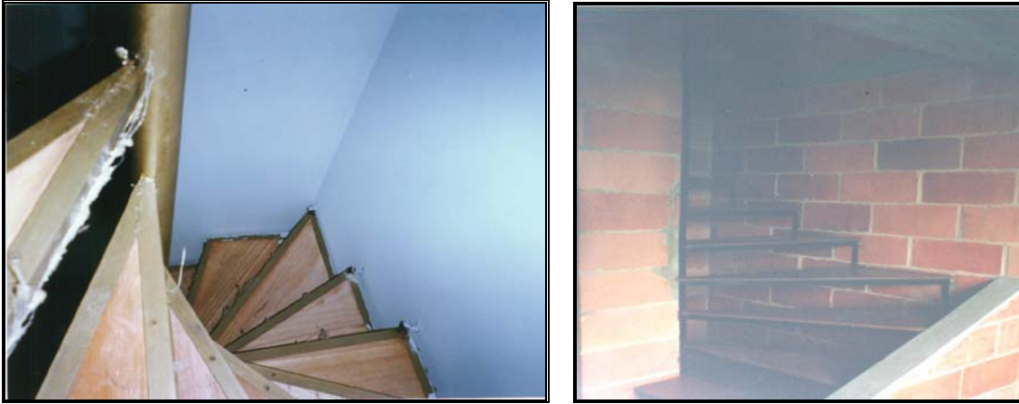
Foto 294-295 Escalera con pasos en madera y estructura metálica
