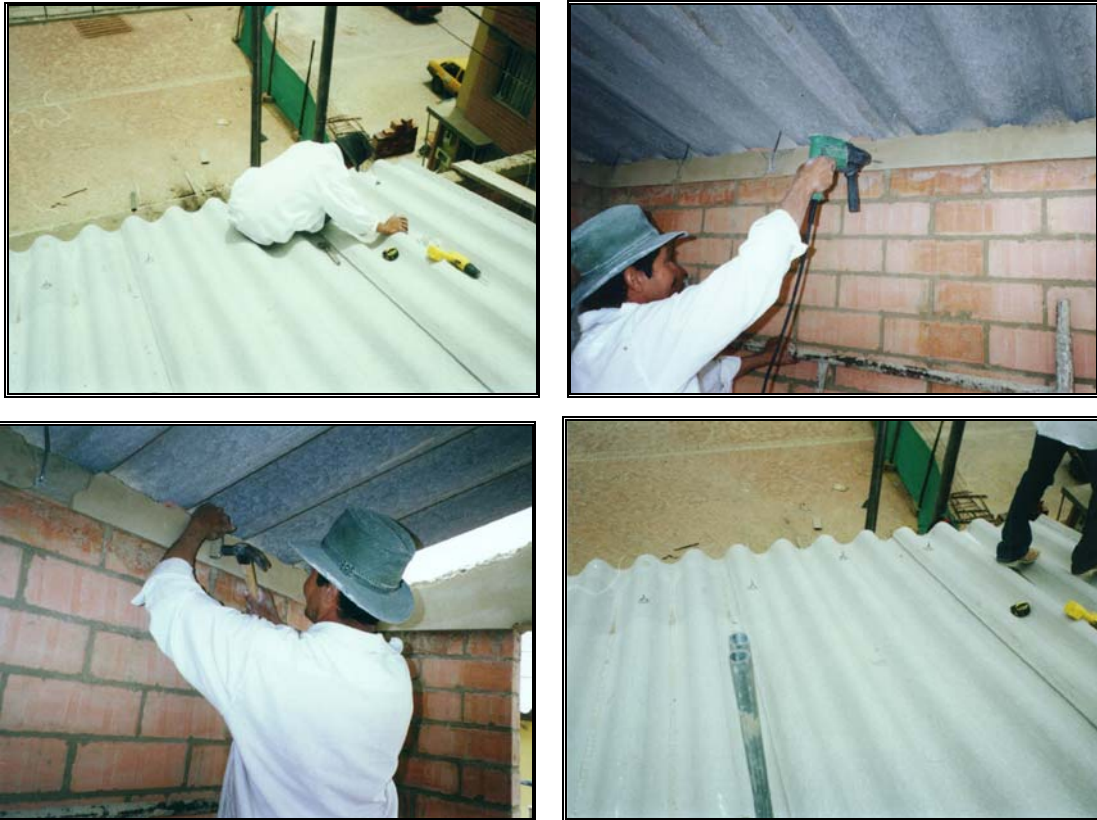
Fotos 316-317-318-319 Aseguramiento interno de la teja mediante ganchos
