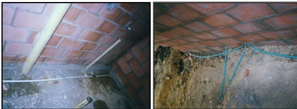
Foto 193. Instalaciones en placa fundida posterior a vigas de cimentación
