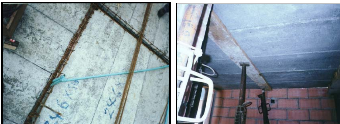
Fotos 247-248 Prelosas de concreto, vigas sobre muro y apoyo inferior
