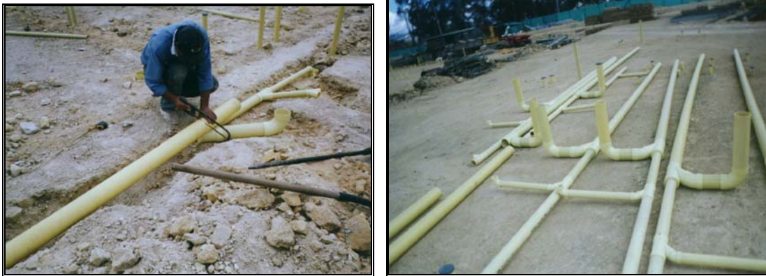
Foto 336-337 Armado y vista final de un ramal o araña
