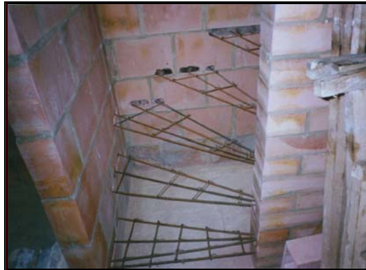
Foto 269 Refuerzo armado y apoyado en regatas
