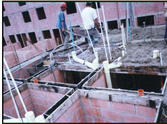
Foto 252. Vaciado y vibrado de torta superior
