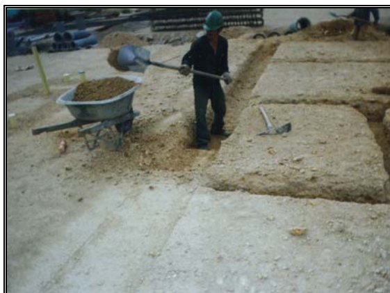
Foto 171 Excavación en recebo compacto para vigas
