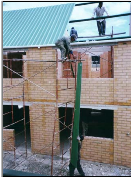
Foto 314 Ascenso de tejas durante la construcción
