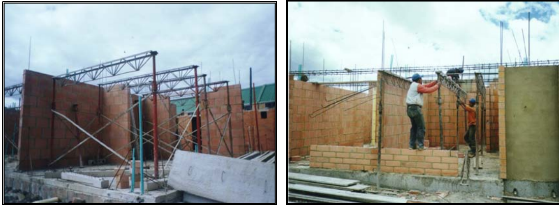
Foto 225. Apoyos de parales, cerchas y crucetas
