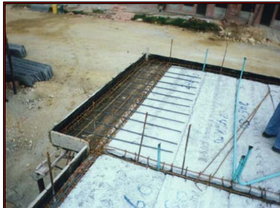
Foto 250 Refuerzo para voladizo
