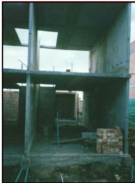
Foto 221. Muros en concreto
