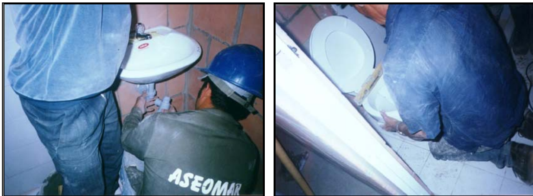
Fotos 341-342 Colocación de aparatos Hidrosanitarios
