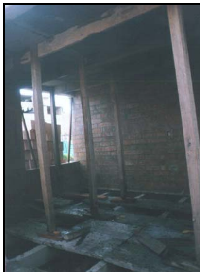
Foto 226. Apoyos en cercos y vigas de madera
