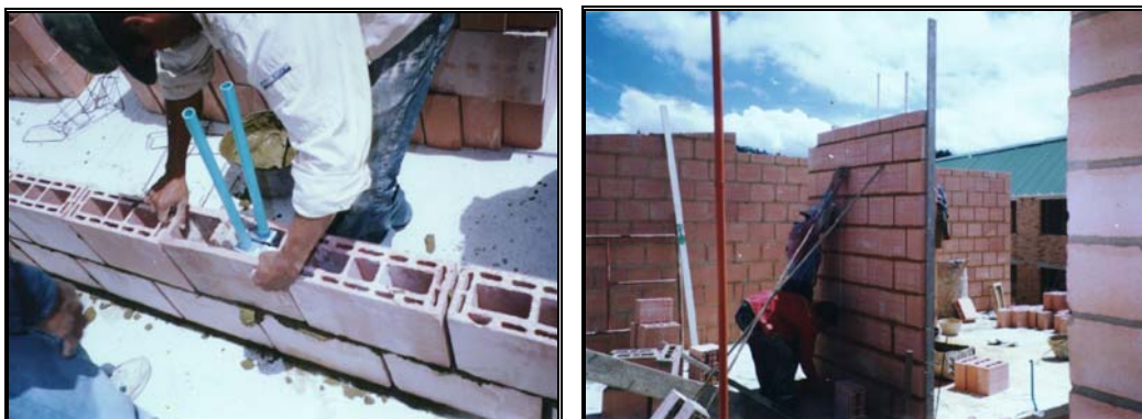
Fotos 210-211. Montaje de hiladas-Plomado de muro
