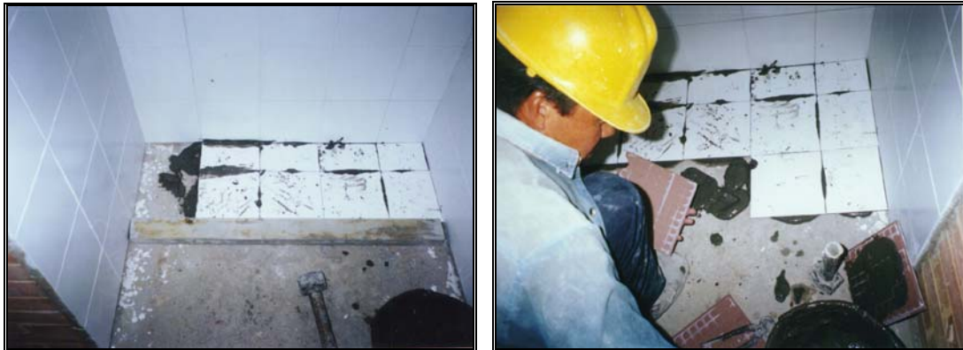
Fotos 370-371 Instalación de baldosas para baño
