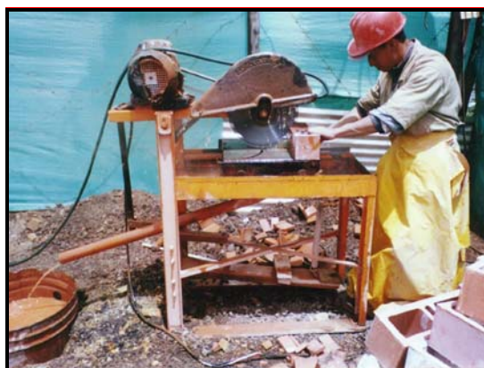
Foto 202. Corte de ladrillos con sierra de disco
