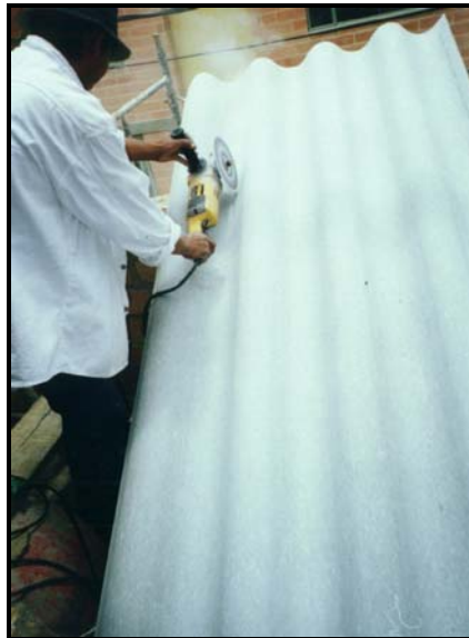
Foto 312 Corte longitudinal de teja con cortadora eléctrica
