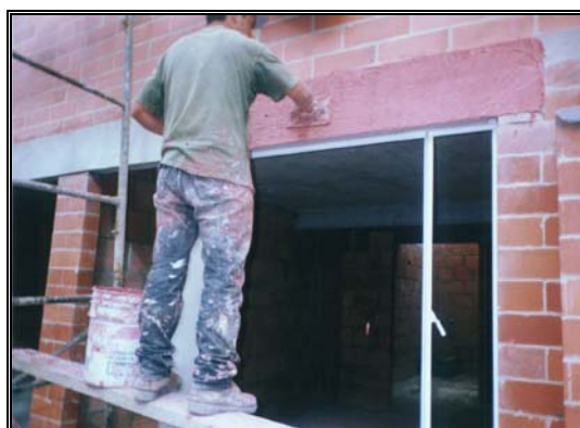
Foto 372-373 Pintura de interiores y exteriores
