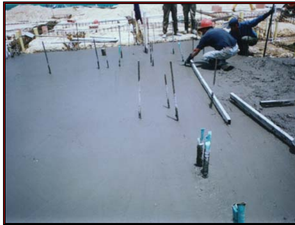
Fotos 185-186 Fundida de placa de contrapiso
