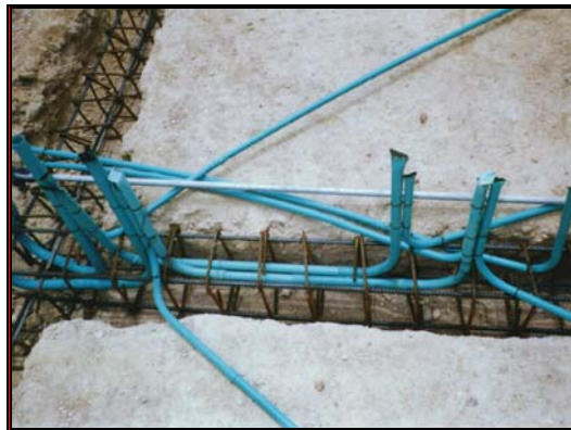
Foto 177 Instalaciones cruzando longitudinalmente refuerzos
