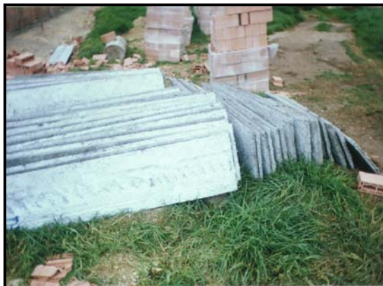
Foto 243 Prelosas de concreto típicas en VIS
