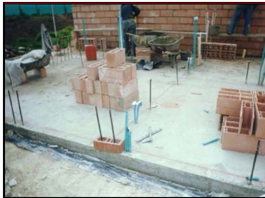
Foto 200. Cimbra para muros y arranque de refuerzos
