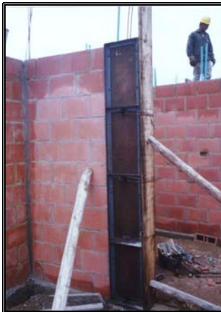
Fotos 218-219. Formaleta típica para columnas de confinamiento
