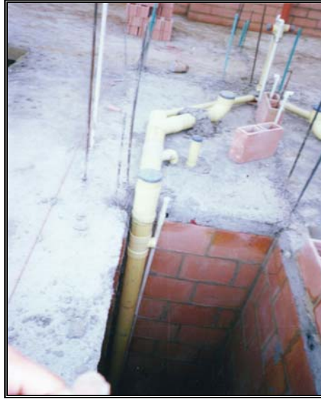
Foto 332 Descenso típico de red sanitaria hacia el patio
