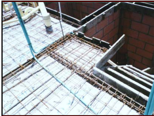
Foto 249 Refuerzo sobre prelosas
