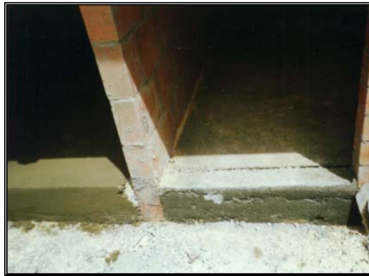
Foto 197. Placa de contrapiso con dilatadores
