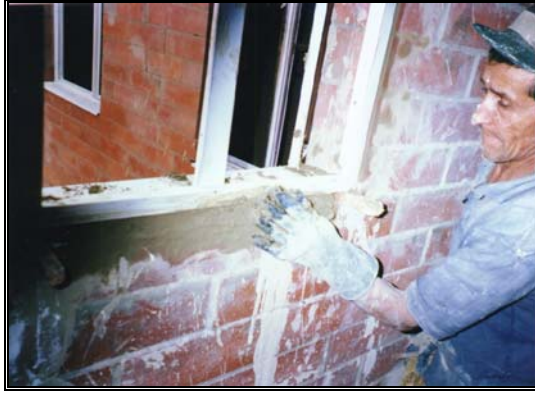
Fotos 366-367-368 Fijación de ventana y relleno de espacios con mortero
