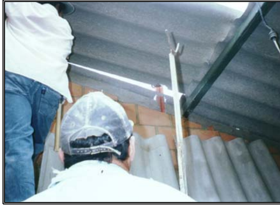
Foto 313 Acomodamiento interno de la teja
