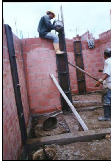
Foto 220. Fundida de columnas
