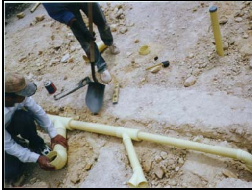
Fotos 168-169 -170 Configuración, excavación y colocación de red sanitaria
