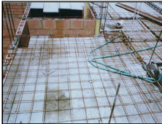
Foto 234.Instalaciones de conduit embebidas en placa
