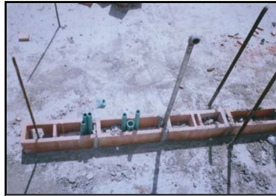
Fotos 328-329-330 Instalación típica tubería para gas. A.Galvanizado
