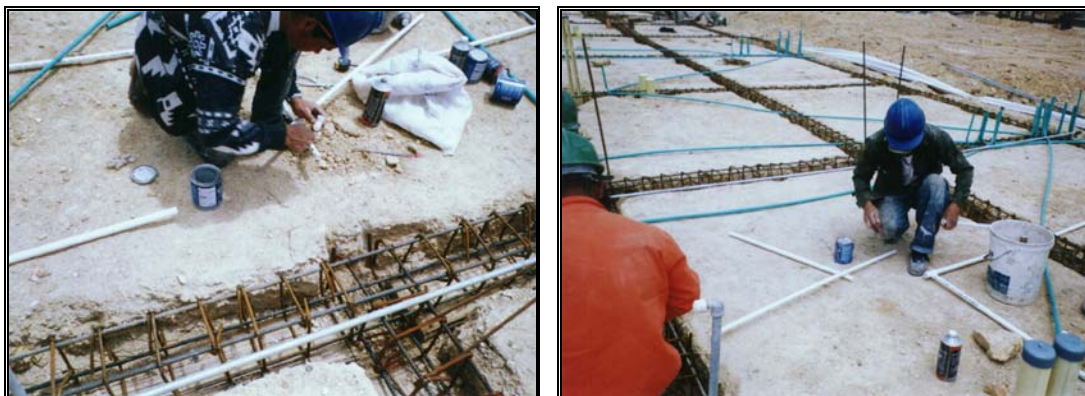
Fotos 344-345 Limpieza y soldadura de tubería PVC-Presión
