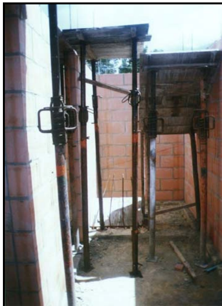
Foto 259 Configuración de apoyos inferiores-escalera
