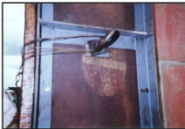
Fotos 218-219. Formaleta típica para columnas de confinamiento
