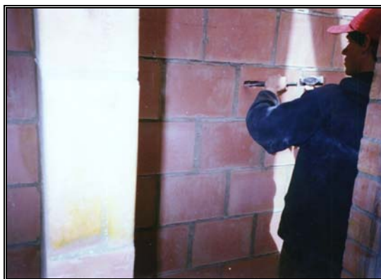
Foto 257. Regata en muros para escaleras
