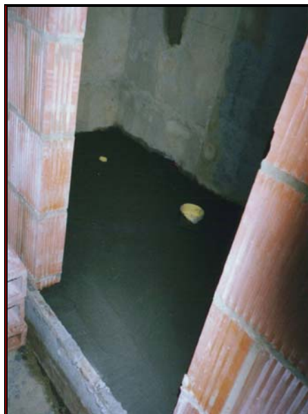
Foto 242 Sobrepiso para instalaciones sanitarias
