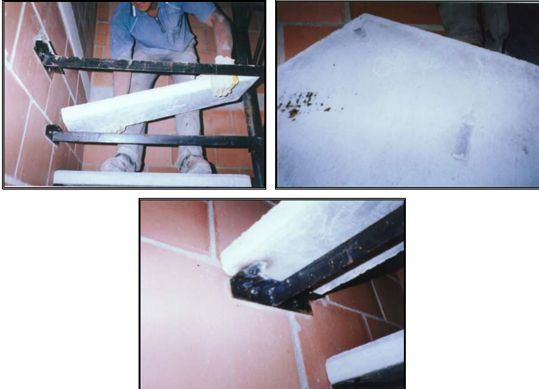
Fotos 288-289-290 Montaje de prefabricados
