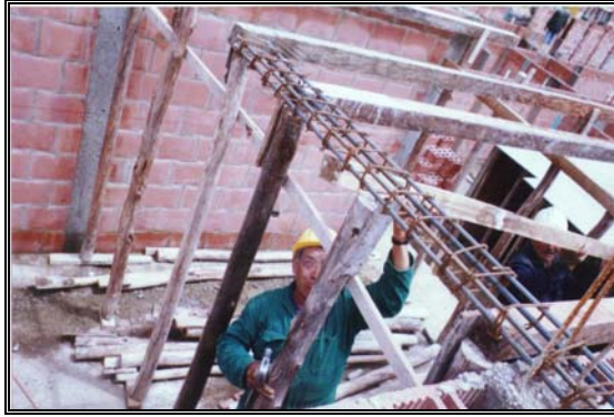
Fotos 229-230 Apoyo de puntales de madera rolliza y vigas de madera
