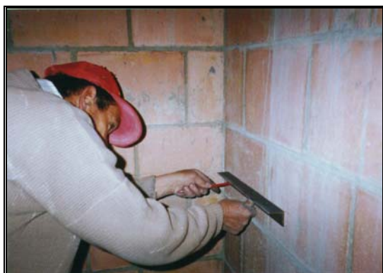
Foto 278-279 Demarcación de pasos en muro-Instalación de láminas
