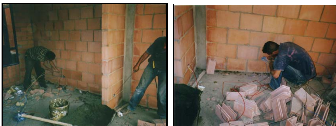
Foto 355-356 Sondeo de cables
