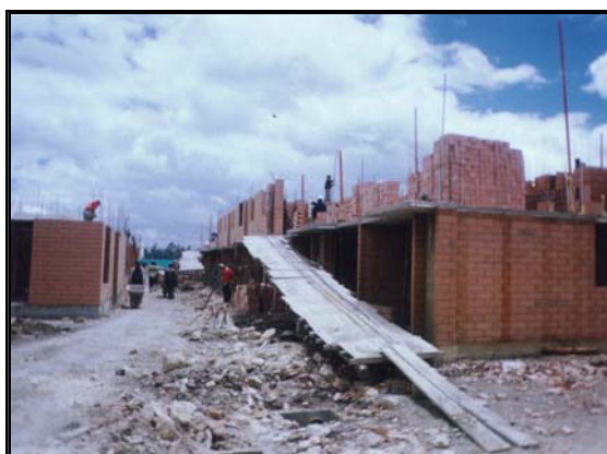
Foto 244 Rampas de ascenso
