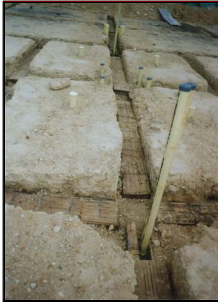
Foto 194 Aligeramientos y espacios para dientes de vigas
