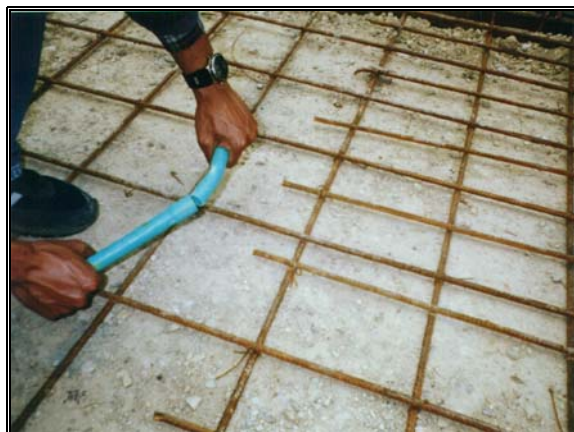
Foto 183 Malla conformada por grafiles atados con alambre
