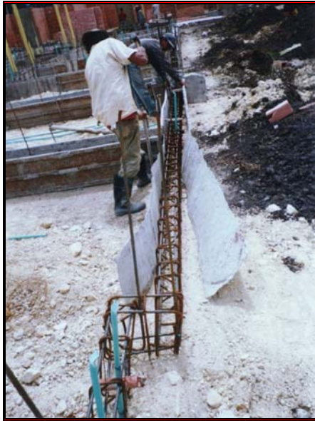
Foto 189 Formaleta metálica a ambos lados
