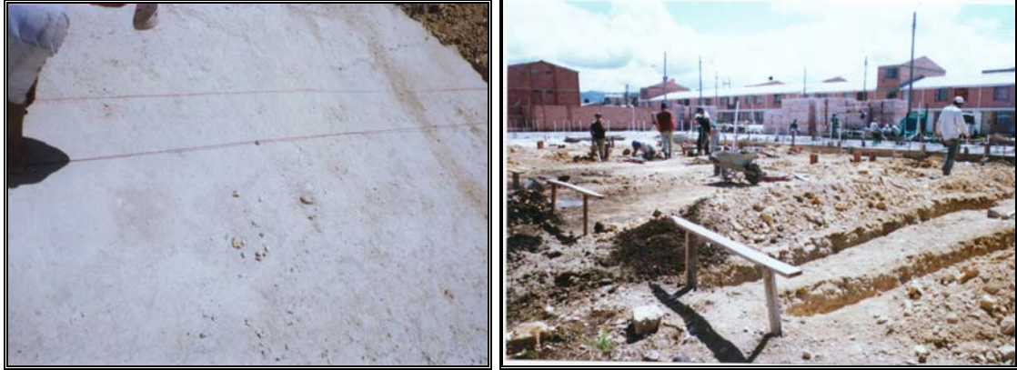
Foto 165-166 Cimbra y localización de caballetes de replanteo
