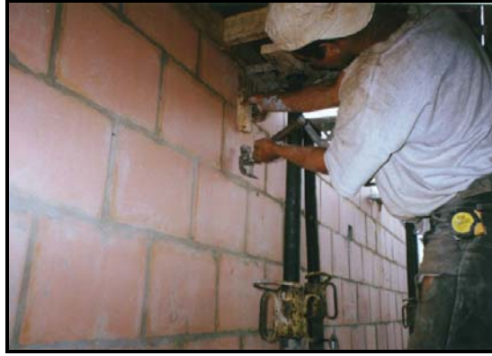
Fotos 231-232-233.Montaje de tableros para cama y colocación de remiendos
