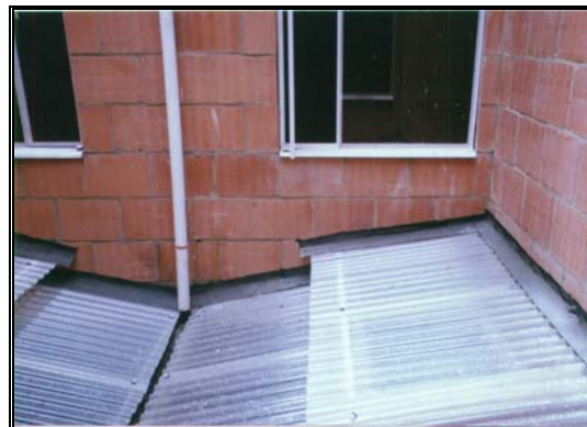
Foto 307 Flanches en esquina de muros
