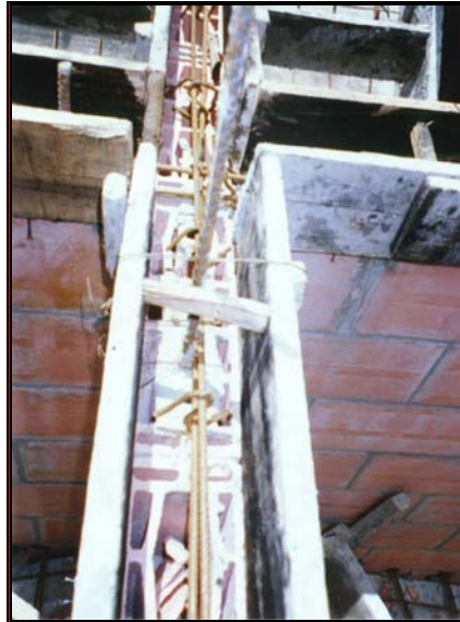
Foto 239. Celdas de bloques taponadas con retal y papel
