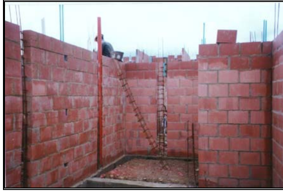
Foto 217. Arranques de refuerzos de columnas
