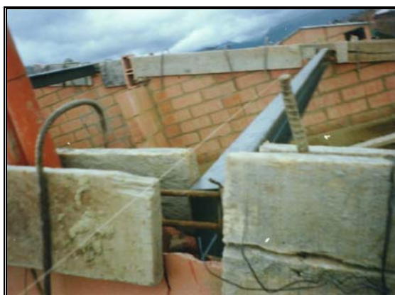
Foto 308 Espacio predispuesto para correa metálica en viga cuchilla
