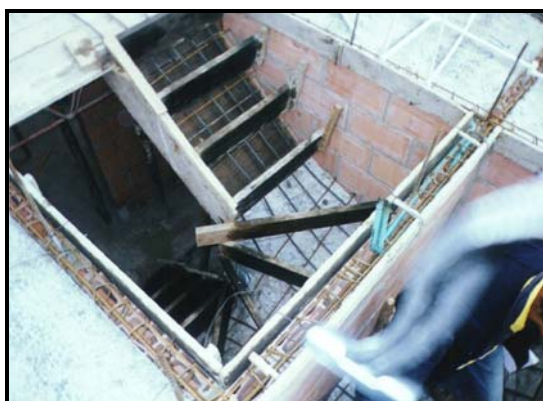
Foto 237-238. Testeros internos (alrededor de escalera) y externos
