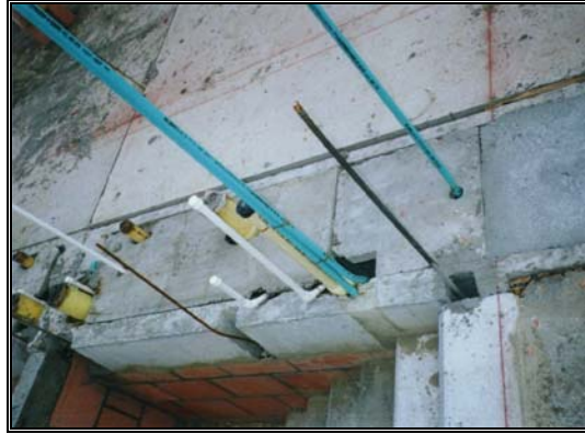
Foto 348 Prolongación vertical de tubería
