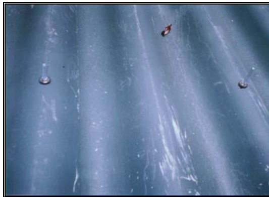
Foto 322 Fijación de tejas Vista externa
