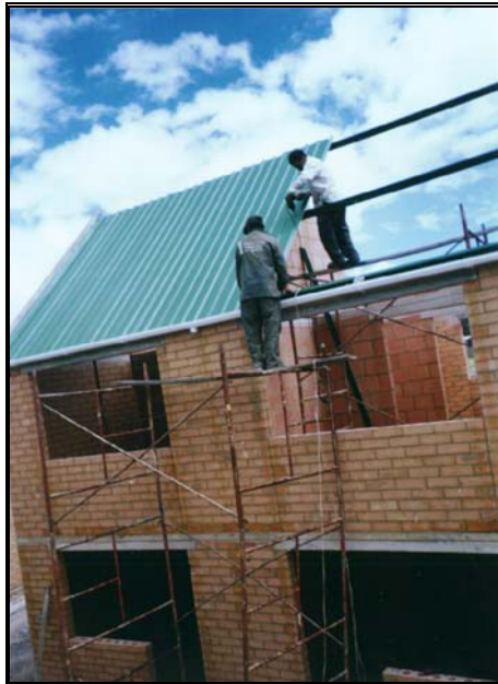
Foto 300 V.I.S. con tejas thermoacoustic
