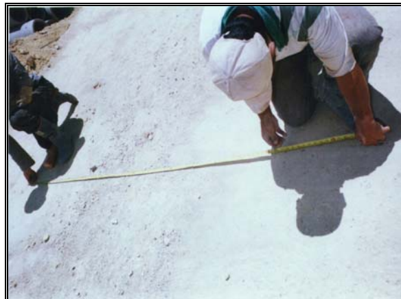
Foto 167 Medición para replanteo de vigas
