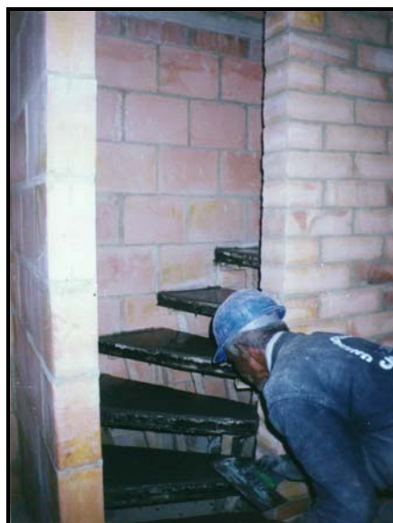
Foto 268 Escaleras embebidas en muro-vista general
