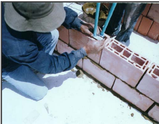
Fotos 352-353 Coordinación levante de muros e instalaciones
