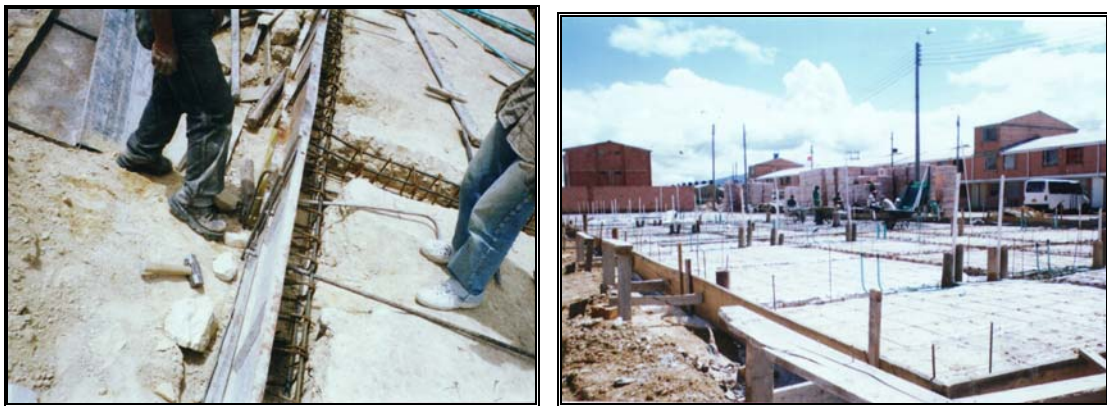
Foto 178 Testeros laterales para vigas y placa
