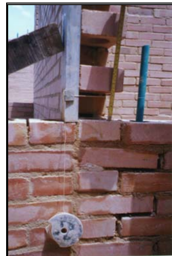
Fotos 352-353 Coordinación levante de muros e instalaciones
