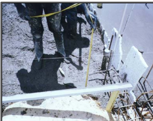
Fotos 187-188. Comprobación nivel de fundida de placa
