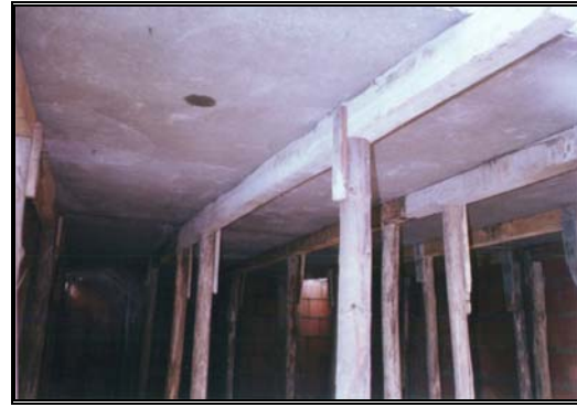
Fotos 229-230 Apoyo de puntales de madera rolliza y vigas de madera
