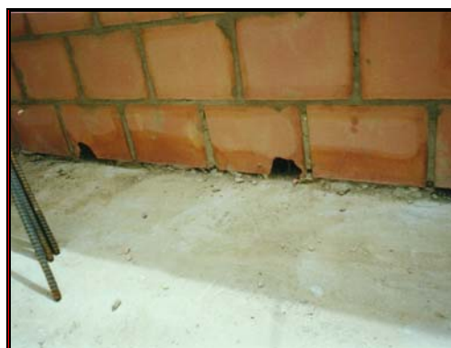
Foto 212, Foto 212A. Ratoneras o Ventanas de inspección
