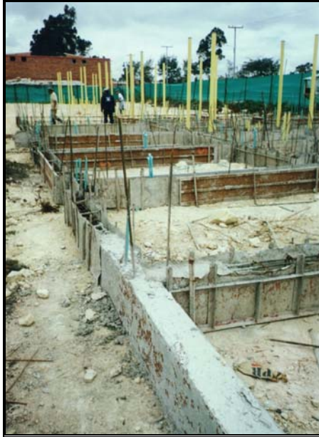
Fotos 190-191 Desmonte de Formaletas
