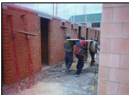
Foto 245-246 Transporte y Ascenso de prelosas
