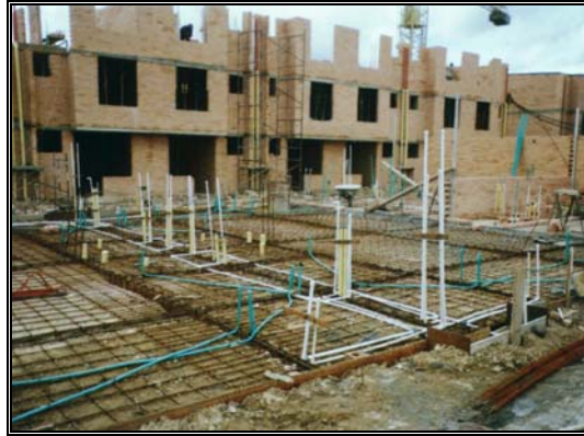
Foto 343 Desarrollo típico de instalaciones de suministro
