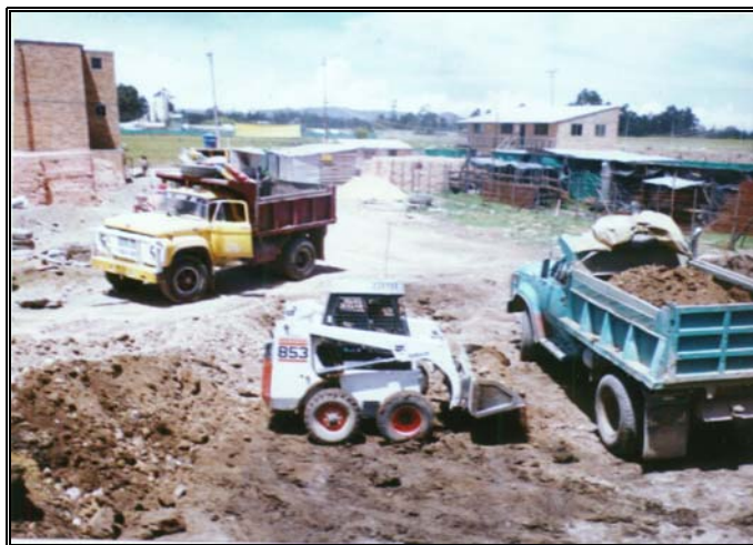
Foto 162 Descapote y limpieza de terreno
