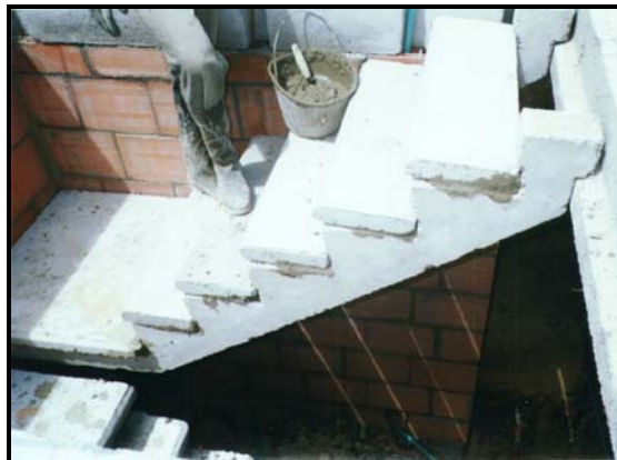
Foto 298 Escalera totalmente prefabrica: Viga de soporte, descanso y pasos
