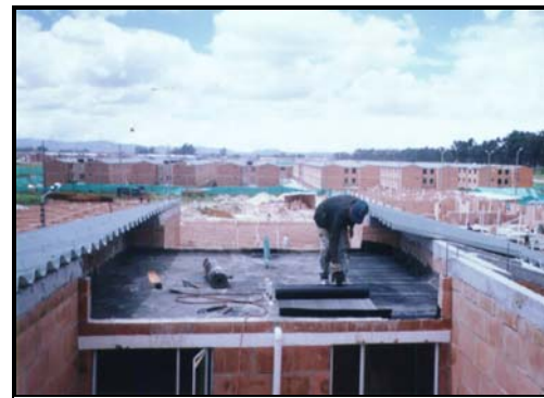
Fotos 303-304-305-306 Impermeabilización de cubiertas
