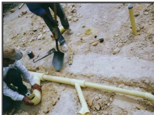
Foto 335 Excavación para red sanitaria
