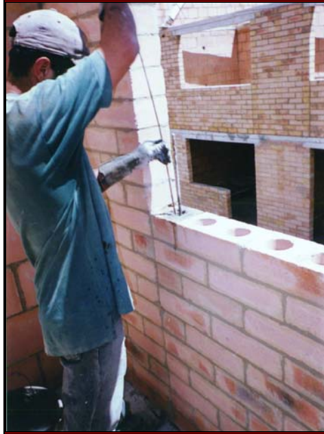
Foto 215. Fundida y vibrado de dovelas
