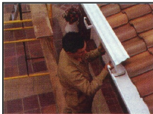
Fotos 357-358 Montaje de canaletas aguas lluvias. Tomado de manual instalaciones de PAVCO
