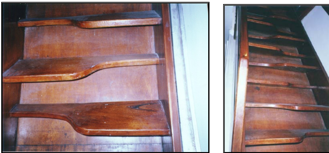
Fotos 296-297 Escaleras a medios pasos
