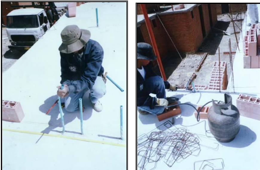
Foto 349-350 Doblado de tubería conduit con soplete
