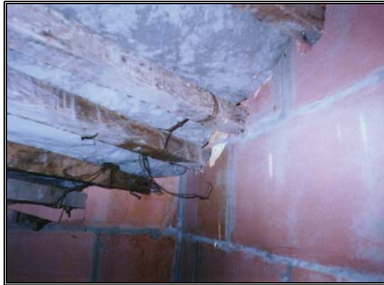
Foto 265 Vista inferior formaleta tramo curvo
