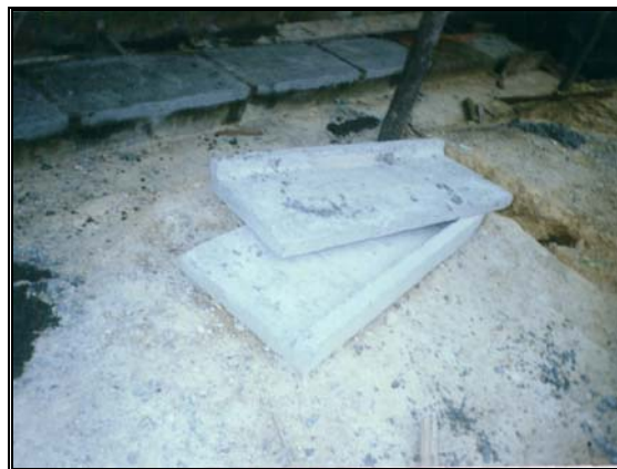
Foto 276 Escalones simples listos para su montaje
