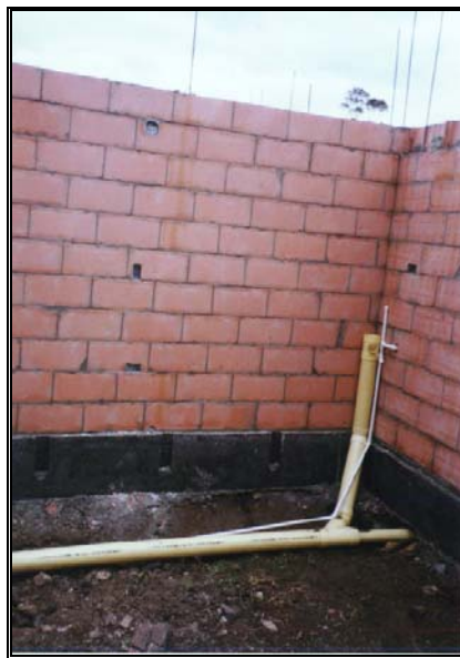
Foto 359 Instalación sanitaria y de suministro colocadas directamente sobre el terreno
