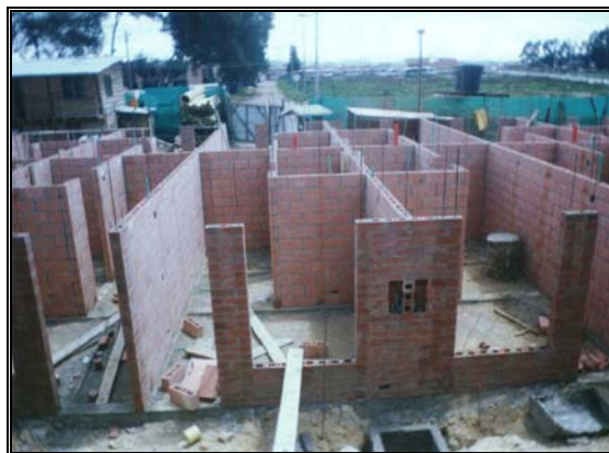
Foto 199. Vista general de proyecto con mampostería reforzada
