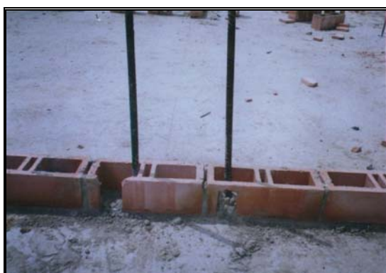
Foto 212, Foto 212A. Ratoneras o Ventanas de inspección
