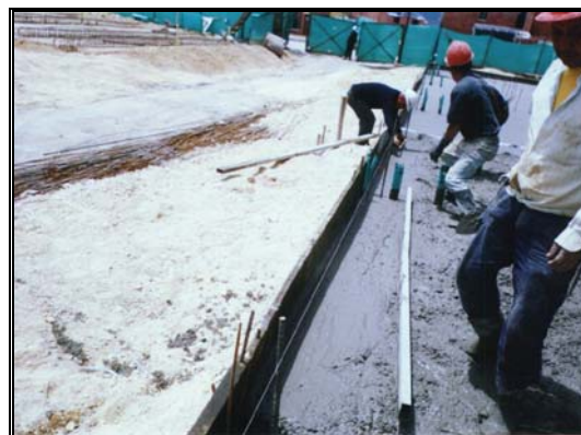
Fotos 187-188. Comprobación nivel de fundida de placa
