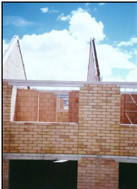
Foto 302 Pendientes elevadas para cubiertas ( 45^{\circ} )
