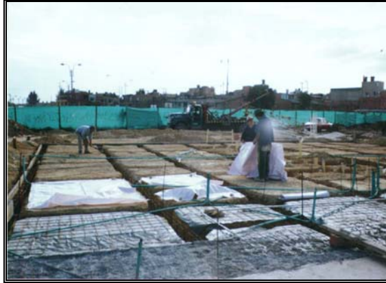
Foto 179 Colocación capas de polietileno
