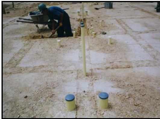
Foto 326 Instalaciones sanitarias enterradas en recebo compacto
