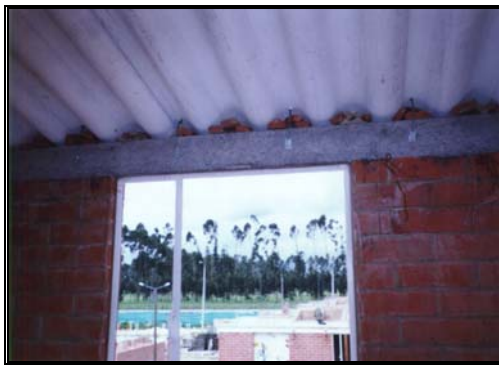
Fotos 324-325 Encorozado de ondulaciones y retal de ladrillo como relleno
