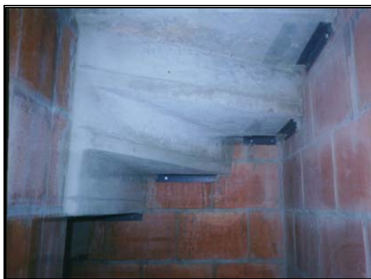
Foto 273. Vista general pasos prefabricados-láminas de soporte
