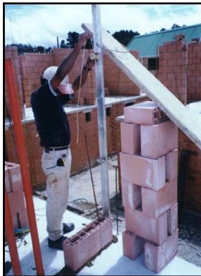
Foto 206. Cabezas de hilada y plomado de guía
