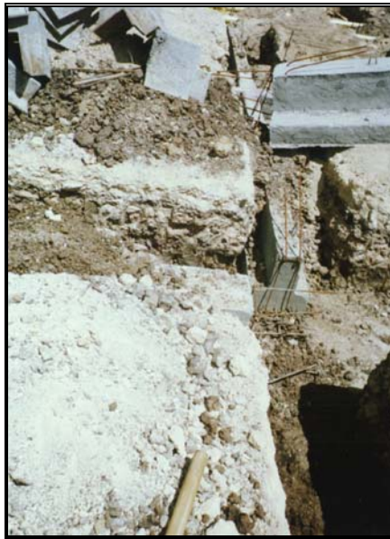
Foto 196 Vigas "T invertidas" prefabricadas
