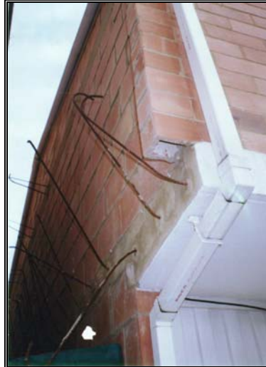
Foto 331 Vista de canaleta típica
