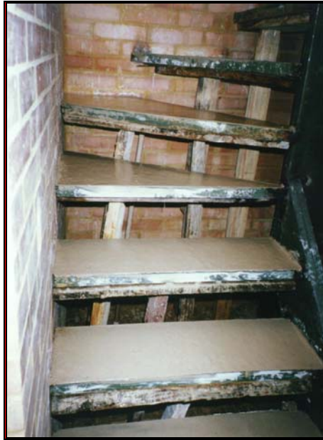
Foto 293 Vista de escaleras recientemente fundidas
