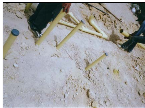
Foto 338 Colocación de la red sanitaria
