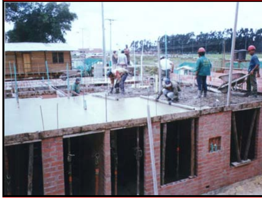
Foto 241 Vaciado y afinado de concreto
