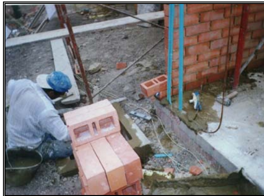
Foto 205. Mortero de base para primera hilada
