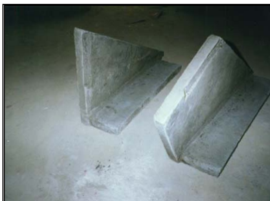
Foto 277 Escalones con contrahuella también prefabricada
