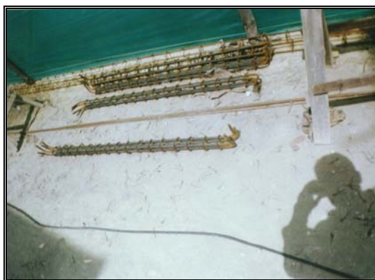
Foto 236 Refuerzo típico de vigas para VIS
