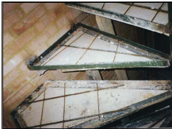
Foto 292 Formaleta inferior y refuerzo
