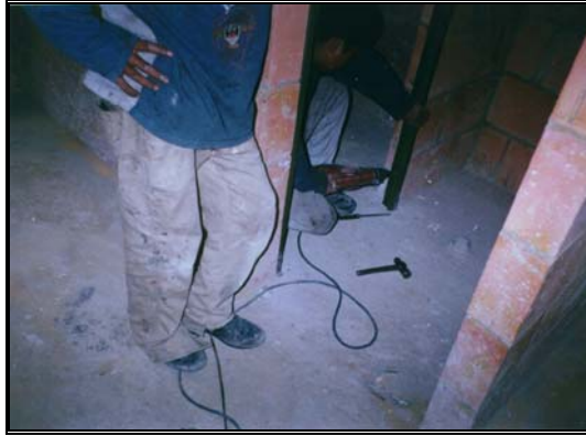
Foto 363 Perforación para aseguramiento
