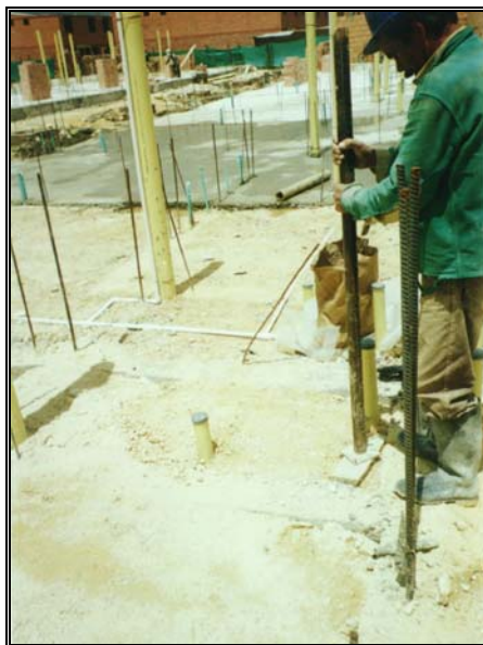
Foto 164. Compactación manual con apizonador
