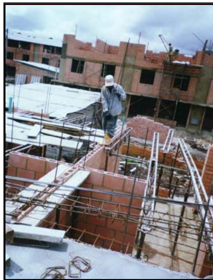
Foto 214. Colocación de refuerzos en celdas
