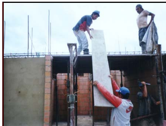
Foto 223. Ascenso de tableros
