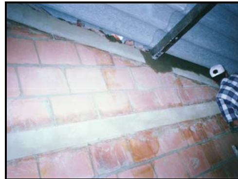
Fotos 324-325 Encorozado de ondulaciones y retal de ladrillo como relleno
