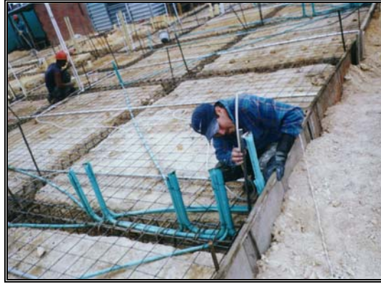
Foto 351 Taponamiento típico tubería conduit
