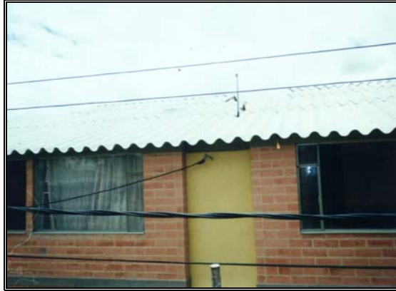
Foto 299 Vista general de casa con tejas en asbesto cemento
