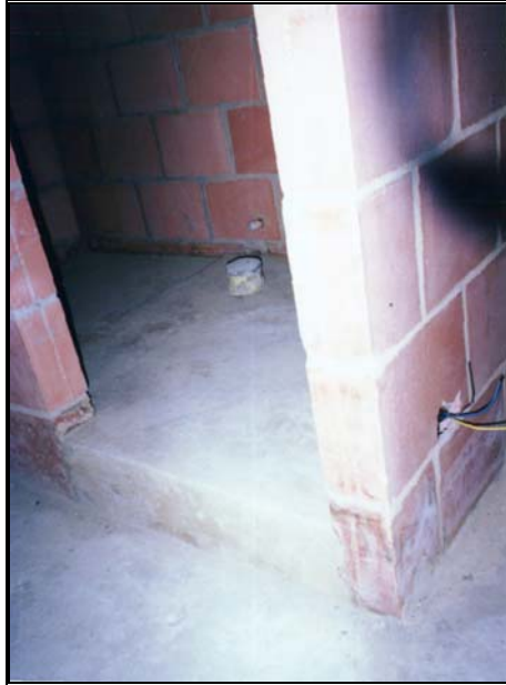
Foto 333-334 Fundida de espacio del baño y Poyo
