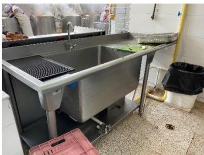
A-2013-251364 Mesón con dos pocetas en acero inoxidable: medidas: 350 cm de largo x 70cm ancho x 90 cm de alto poceta de 55cm x 55cm x 35cm de profundo; cubierta en calibre 16; piso en calibre 18; pata de en tubo redondo en acero inoxidable 2" con patas niveladoras en aluminio fundido con llave de pedal y mezclador.
