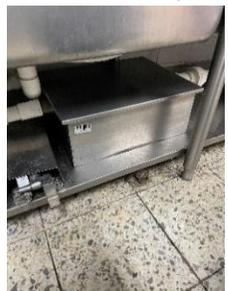
**A-2013-251405** Trampa de grasas en acero inoxidable: en calibre 16 filtros salidas y entradas en 1 1/2 registro para lavado de 3/4 Dos pocetas en una trampa.
