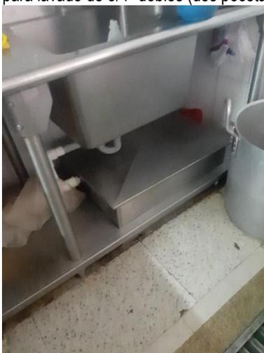
**A-2017-336728** Mesa de trabajo: Medidas: Largo: Ancho: 0.70 m, Alto: 0.90 m; Cubierta en acero inoxidable calibre 16 Ref: 304, entrepaños en acero inoxidable calibre 18 Ref. 304 con salpicadero y doble media caña, patas en tubo redondo en acero inoxidable de 2" con patas niveladoras en aluminio fundido (Corresponde a dos mesas de trabajo una de 1.09 ML y una de 2.38 ML, para un total de 3.47 ML)
