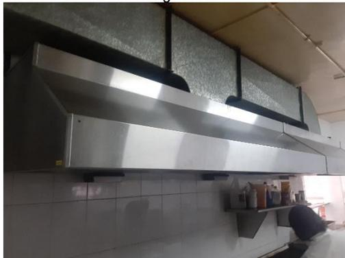
**A-2016-315643** Ducto de extracción de aire fabricado en lámina galvanizada calibre 24, con rache en Angulo de 1"X1/8" de espesor, para uniones a tope con tornillo guasa y arandela sellado con silicona alta temperatura, soportería de anclaje. Medidas 0.40 mts X 0.40 mts, aproximadamente 21 mts de largo, incluye accesorios para instalación.
