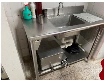
Lava papa en acero inoxidable: medidas: 220cm de largo x 120cm de ancho x 90cm cubierta en calibre 16, cuerpo y piso en calibre 18; patas en tubo redondo en acero inoxidable de 2" con patas niveladoras en aluminio fundido.
