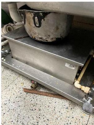
**A-2013-251408** Trampa de grasas en acero inoxidable: en calibre 16 filtros salidas y entradas en 1 1/2 registro para lavado de 3/4 Dos pocetas en una trampa
