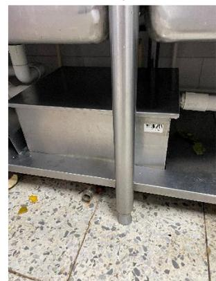
**A-2013-251406** Trampa de grasas en acero inoxidable: en calibre 16 filtros salidas y entradas en 1 1/2 registro para lavado de 3/4 Dos pocetas en una trampa
