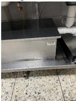
**A-2013-251407** Trampa de grasas en acero inoxidable: en calibre 16 filtros salidas y entradas en 1 1/2 registro para lavado de 3/4 Dos pocetas en una trampa
