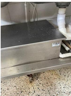
**A-2013-251409** Trampa de grasas en acero inoxidable: en calibre 16 filtros salidas y entradas en 1 1/2 registro para lavado de 3/4 Dos pocetas en una trampa
