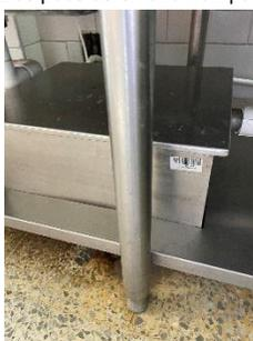
**A-2013-251404** Trampa de grasas en acero inoxidable: en calibre 16 filtros salidas y entradas en 1 1/2 registro para lavado de 3/4 Dos pocetas en una trampa
