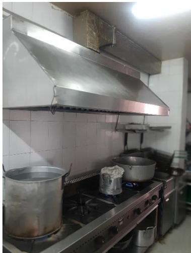
**A-2016-315642** Campana de extracción tipo pared fabricada en acero inoxidable calibre 20 ref calibre 22 ref 430 pulido y brillado, recolector perimetral de grasas con cubierta para condensado, y un (1) sosco de salida para ducto de extracción. Medidas 2.30 mts de largo X 0.80 mts de ancho X 0.50 mts de alto
