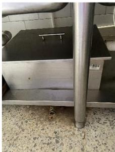
**A-2013-251403** Trampa de grasas en acero inoxidable: en calibre 16 filtros salidas y entradas en 1 1/2 registro para lavado de 3/4 Dos pocetas en una trampa
