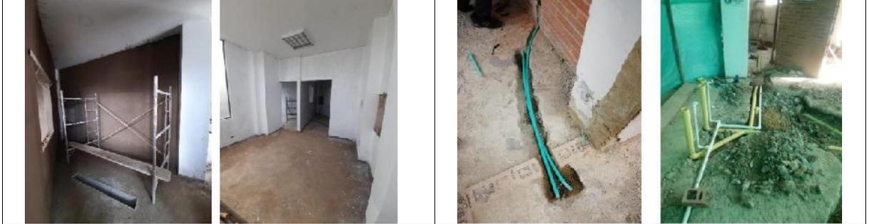
FOTO 3: Panete y pintura - Restaurante FOTO 4: Instalación de tuberías de agua y electricidad - Restaurante
